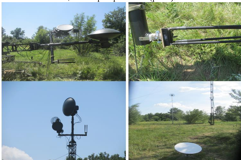
Рис.2. Встановлення радіостанції на щоглу
